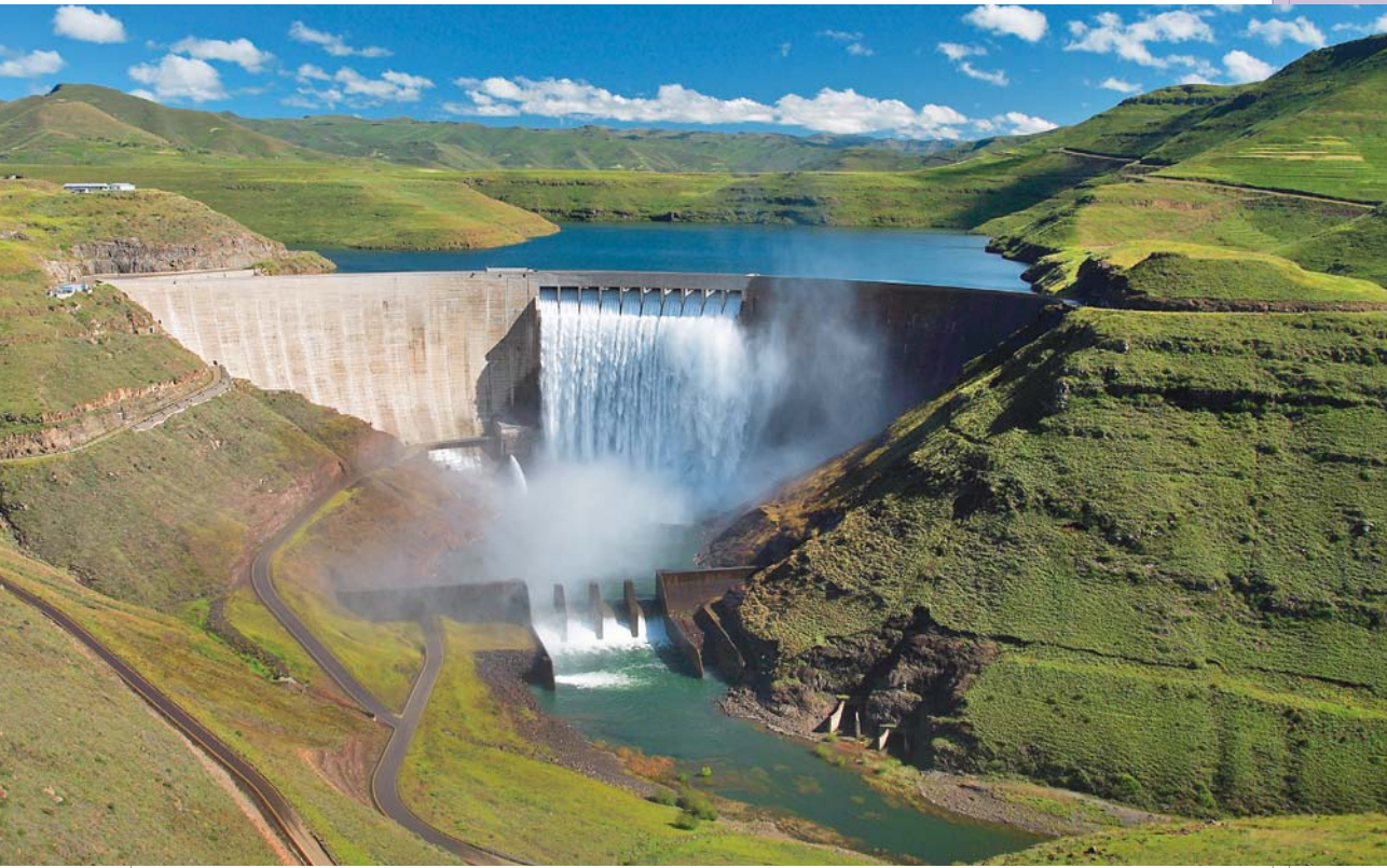
Ryc. 23.7. Zapora Katse na rzece Malibamatso w Lesotho wybudowana w 1997 r.
